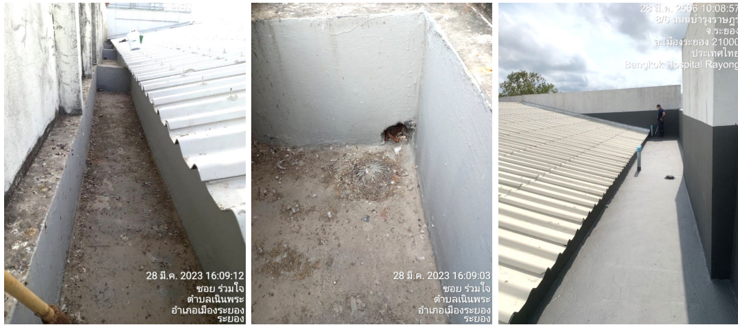
รูปที่ 2-28 เจ้าหน้าที่ตรวจสอบและทำความสะอาดรางระบายน้ำ
