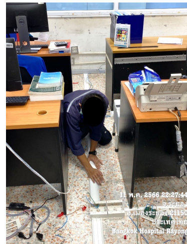
รูปที่ 2-20 งานซ่อมแซมจุดเชื่อมต่อการเดินสายไฟ และอุปกรณ์ต่างๆ
