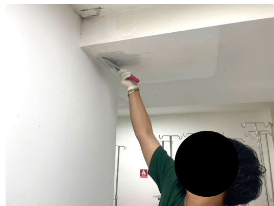
รูปที่ 2-22 การอุดรอยรั่วตามผนัง เพดาน เพื่อไม่ให้สูญเสียความเย็น
