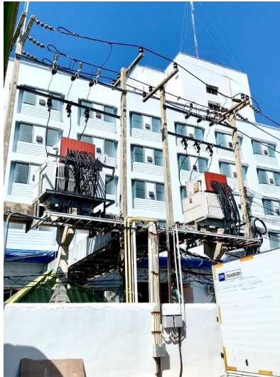
รูปที่ 2-19 หม้อแปลงไฟฟ้าของโครงการ
