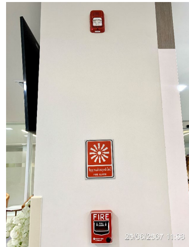
ชุดกดแจ้งเหตุแบบใช้มือดึง Manual Station และอุปกรณ์ส่งสัญญาณเสียง Strobes and Horns
